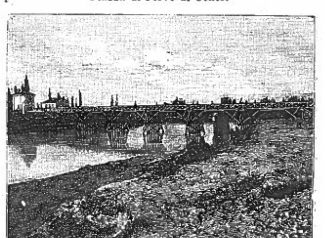
Ponte provvisorio in legno sul Reno.
